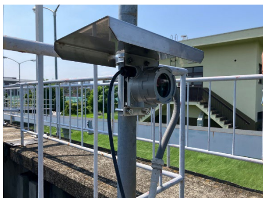
着水井水位計修繕（交換）
