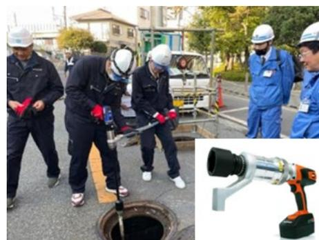
電動バルブ開閉工具、操作デモ
