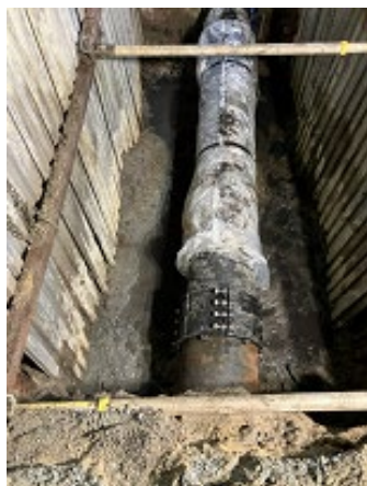
緊急修繕完了：大野3丁目
