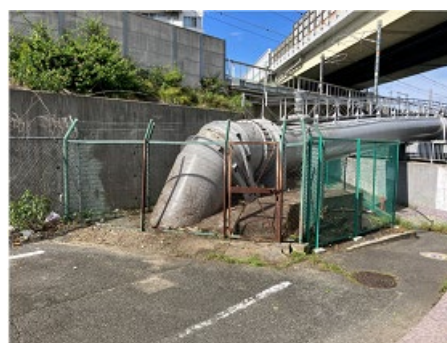
管路用地等雑草伐採後：高殿 1-9
