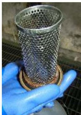
ストレーナ清掃：鶴見配水場
