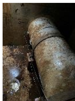
流量計：桜宮配水場
