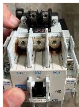
排泥ポンプ盤電磁接触器交換：東淀川浄水場
