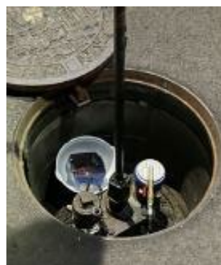
水圧調査状況
