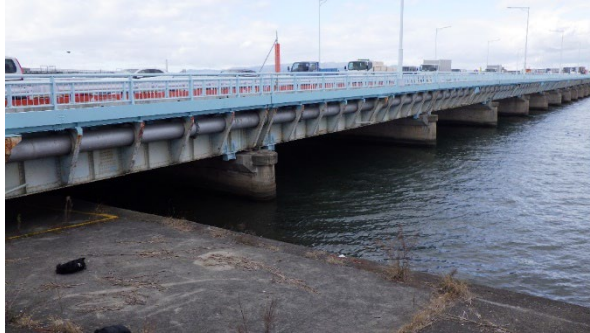
写真 水管橋調査（陸上：淀川大橋）
