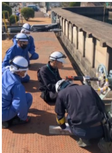
写真 沈殿池（1号）の清掃 電動開閉工具によるバルブ操作
