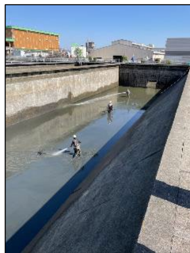
写真 沈殿池（1号）の清掃 清掃状況
