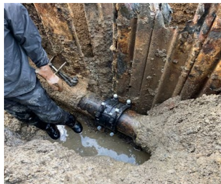
写真 漏水修繕状況
