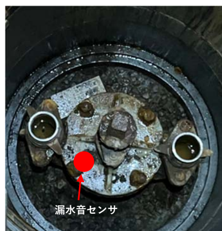
写真 漏水音センサ設置イメージ
