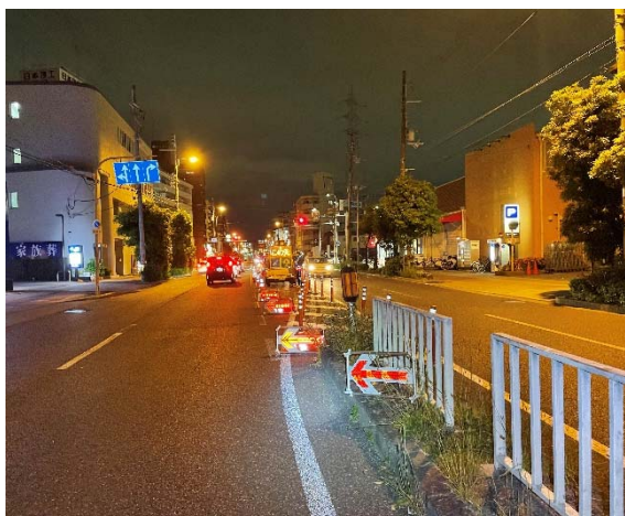
写真 漏水音センサ設置（夜間交通規制）
