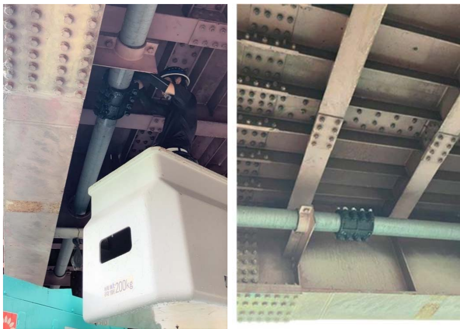
写真 漏水修繕状況 (水管橋 添架管での修繕)
