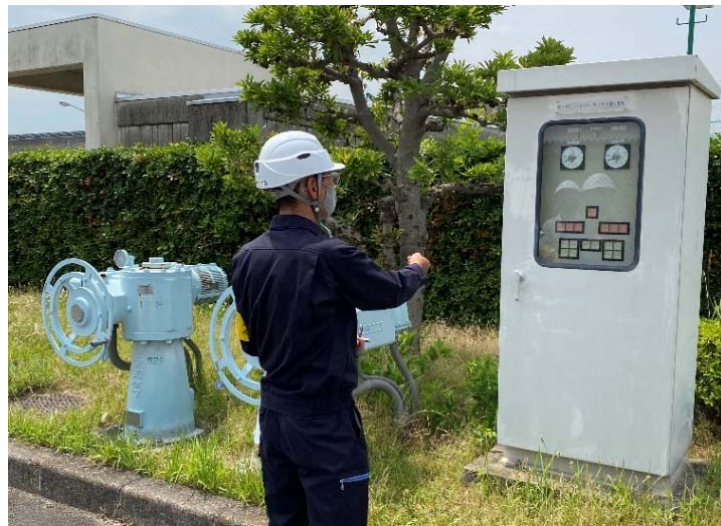
写真 巡視点検状況
